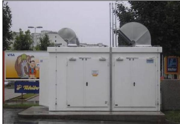
Zur Erdgastankstelle gelangt das Erdgas durch unterirdisch verlegte Leitungen. Die Leitungen bestehen entweder aus Stahl oder Kunststoff. Erdgastankstellen sind mit Not-Aus-Systemen ausgerüstet, deren Betätigung im Gefahrfall Vorrang hat.
